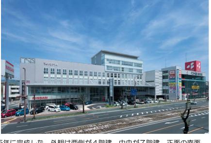
し、ふたつをつなぐかたちで中央部分が2015年に完成した。外観は西側が4階建、中央が7階建、正面の南面はガラス張り、大きな庇を取り付けて風土に適した形態とし、構造が鉄骨造である。
