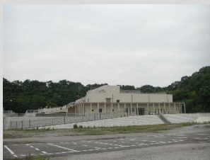
長浜雨水ポンプ場
