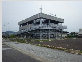
津波避難タワー
