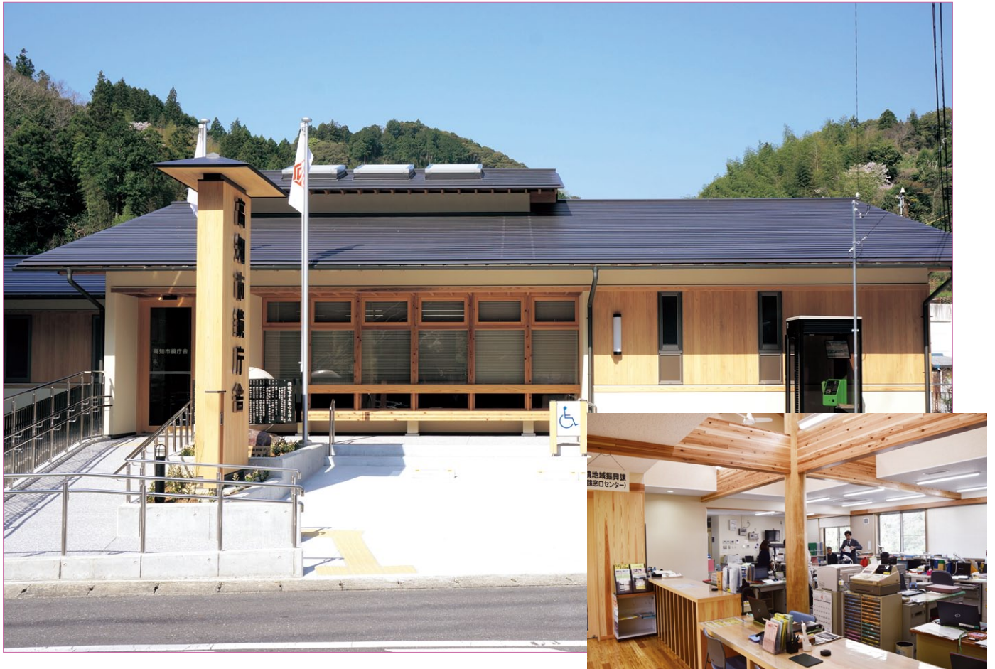
天窓から光が差し込む明るい庁舎（平成29年2月27日に開庁した鏡庁舎）
