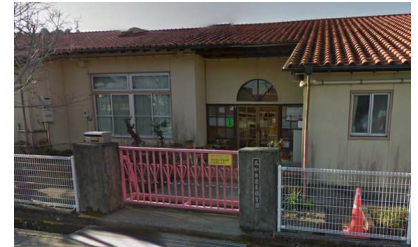
【耐震補強予定の愛善保育園】
