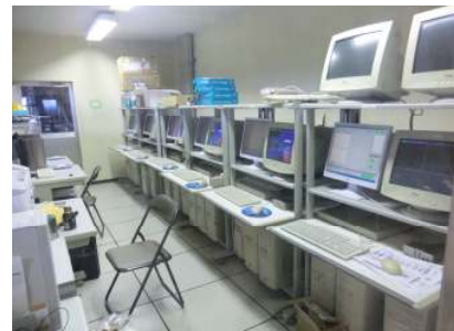
データ処理設備
