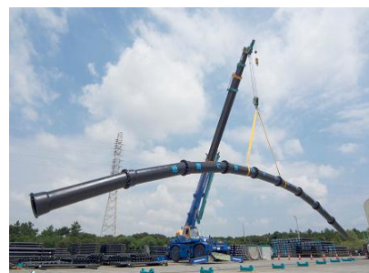
基幹管路耐震化
