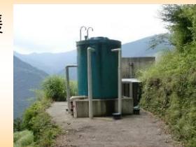
中山間地域における飲料水供給施設
