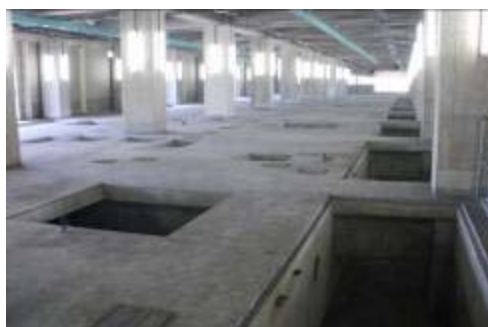
着工前 (平成 26 年 4 月時点)
