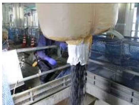
第二 B R 槽への担体投入状況 (平成 26 年 12 月撮影)
