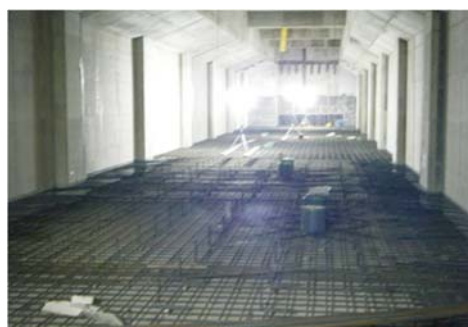
反応タンク内の改造工事状況 (平成 26 年 8 月撮影)
