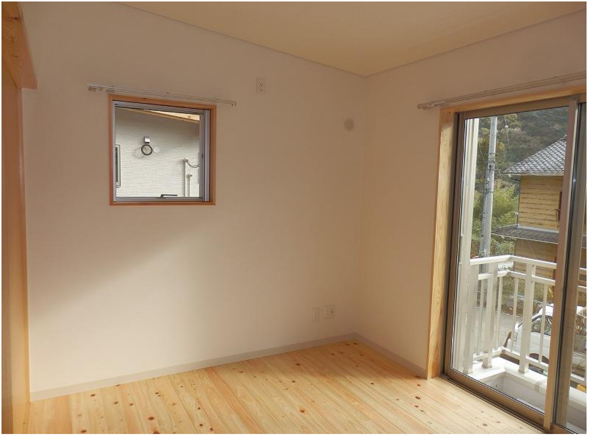
②1 西棟 2階個室(東)
