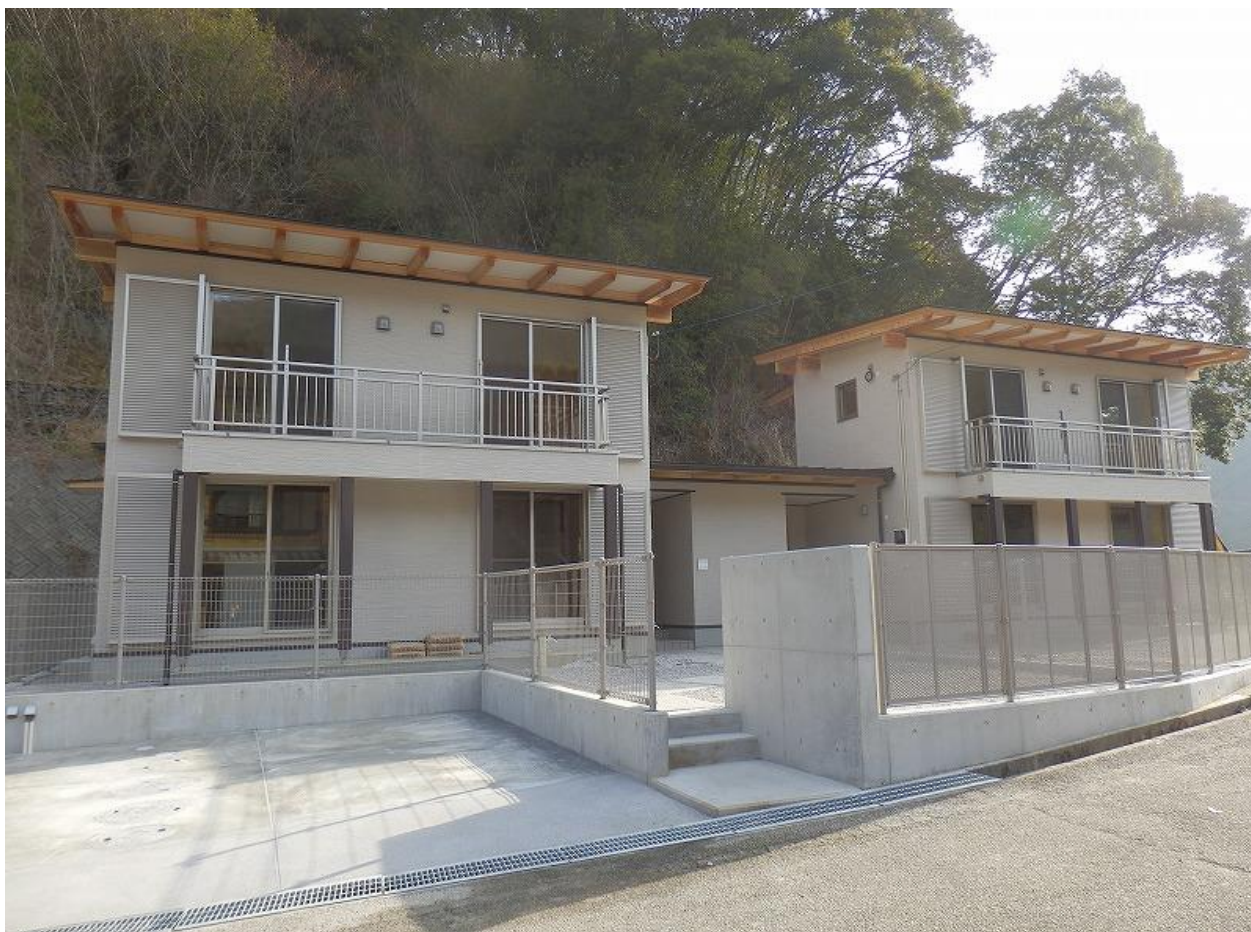
2号棟(左側の建物) 正面
