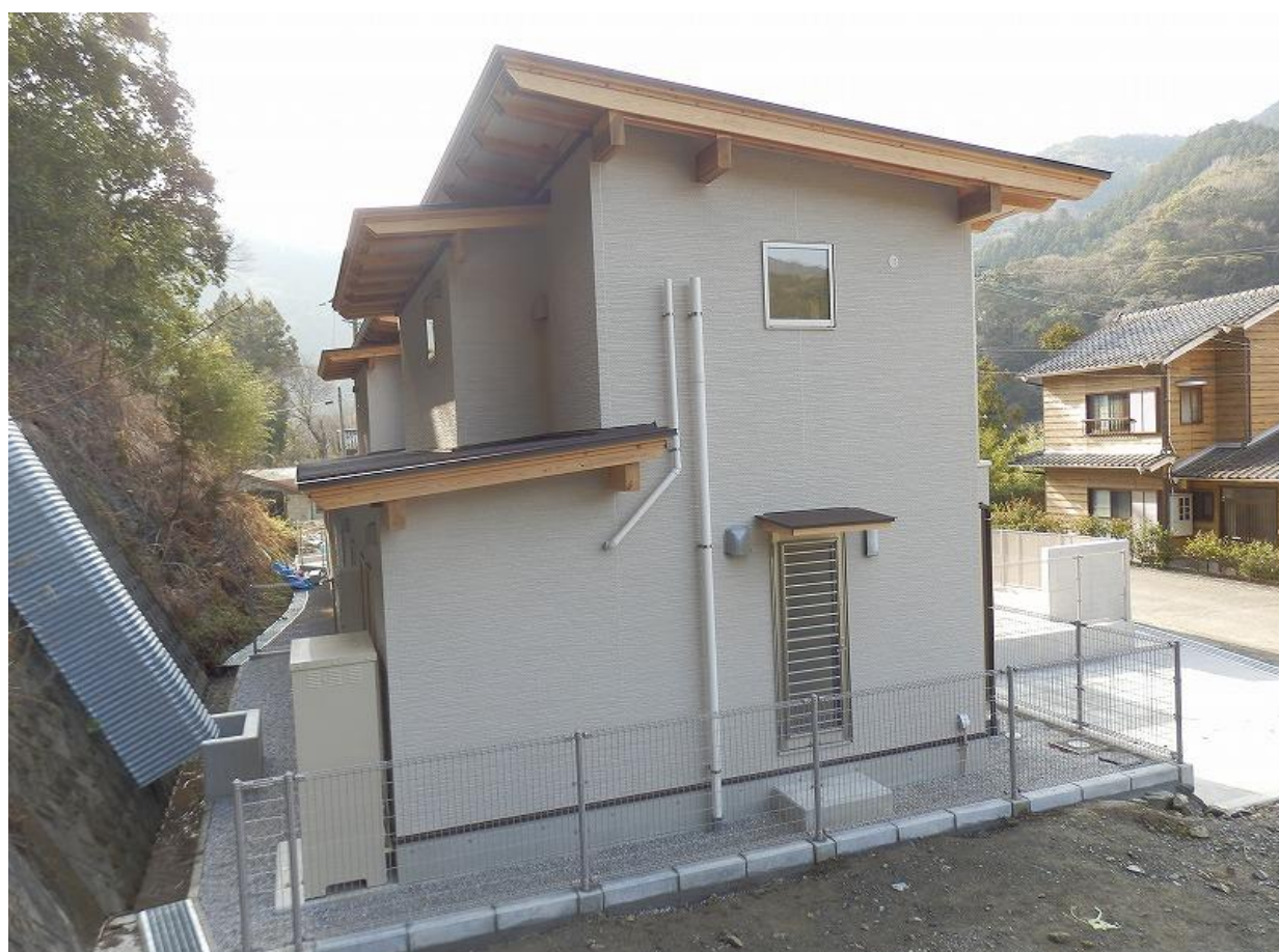
2号棟 外観(西側)
