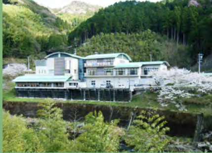
【鏡文化ステーションRIO（リオ）】 鏡ダムの少し下流にあり、施設内では環境に優しいバイオマス（木質）燃料で温めた温泉が楽しめます。
