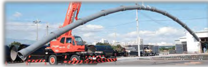
耐震管の吊り上げ試験 (日本ダクタイル鉄管協会)
