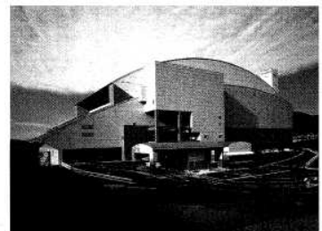
工場棟 (南東より)
