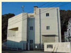
仁井田ポンプ場
