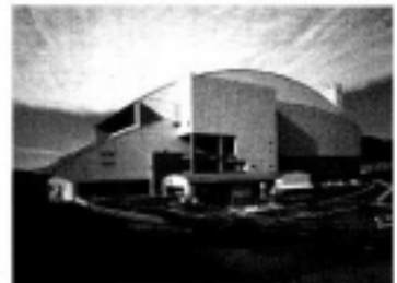
工場棟 (南東より)
