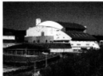
工場棟 (南西より)
