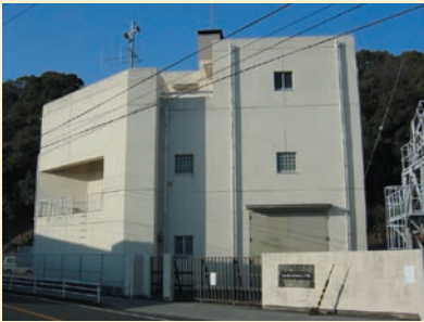
仁井田ポンプ場
