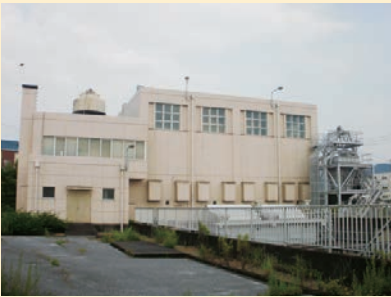
米田古川ポンプ場
