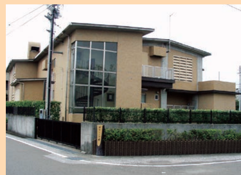
初月ポンプ場
