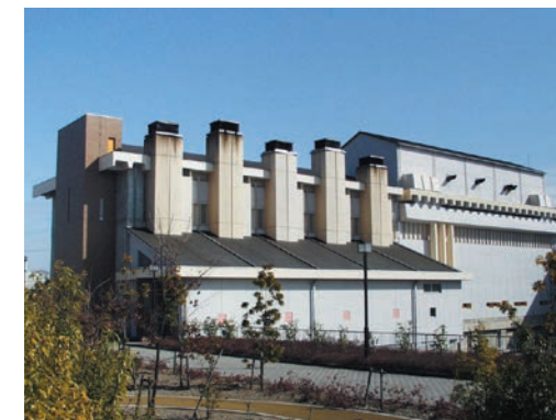
海老ノ丸ポンプ場
