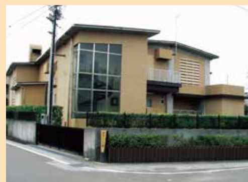
初月ポンプ場
