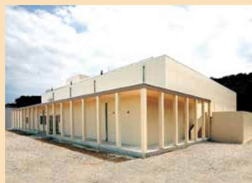
長浜雨水ポンプ場
