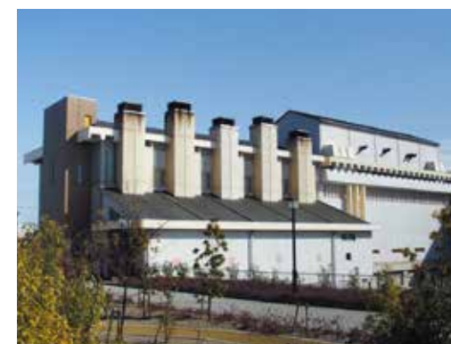
海老ノ丸ポンプ場
