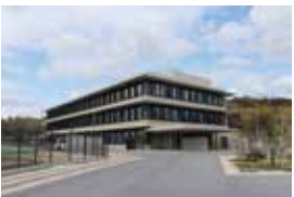
現在の上下水道局本庁舎
