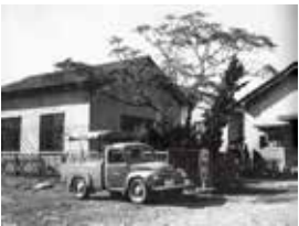
帯屋町の庁舎
