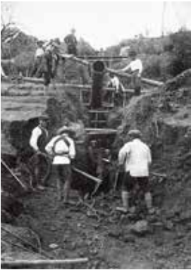
創設時の工事風景
