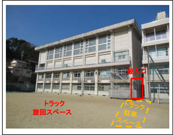
②搬入口(遠景)
