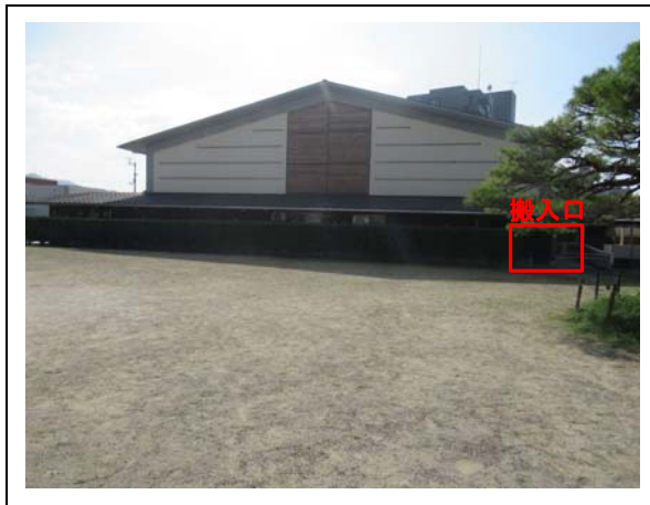
③搬入口(遠景)
