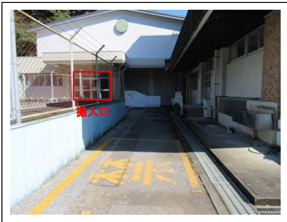
③搬入口(遠景)
