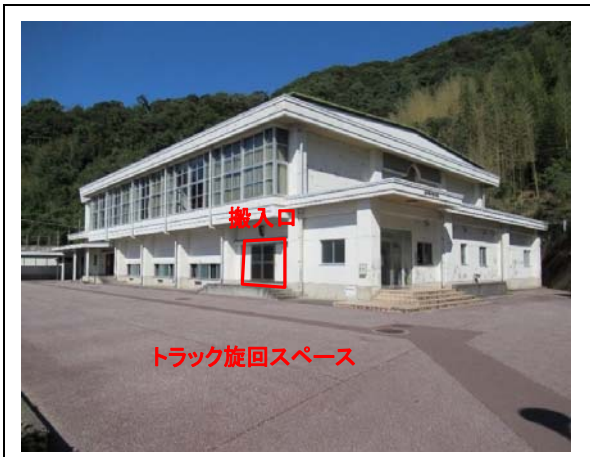
③搬入口(遠景)
