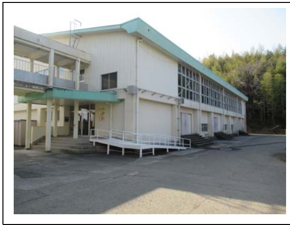
③搬入口(遠景)
