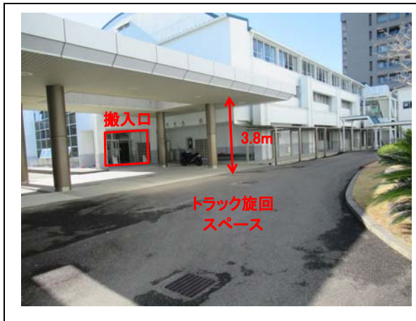
③搬入口(遠景)
