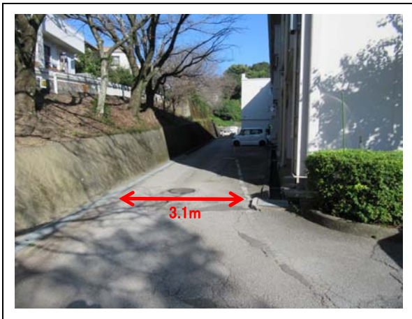
③進入路 道幅3.1m
