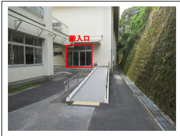
④搬入口(近景)
