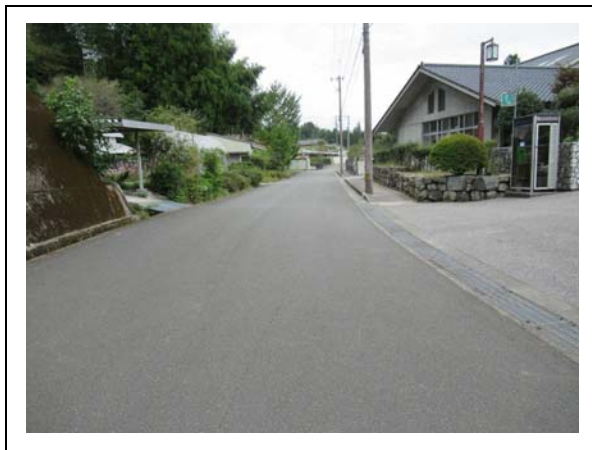
④周辺道路
