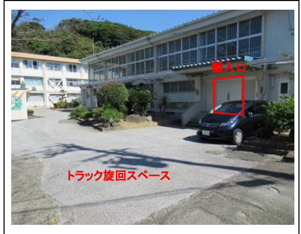
②搬入口(遠景)
