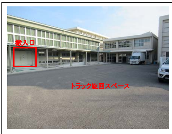
③搬入口(遠景)
