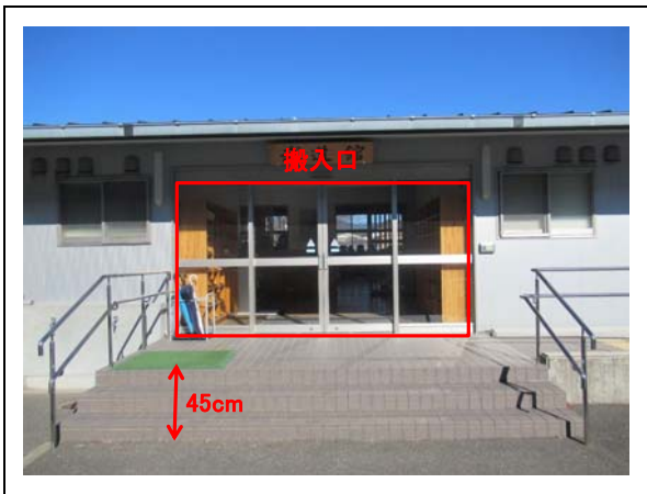
④搬入口(近景)
