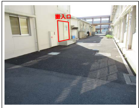
④搬入口(遠景)
