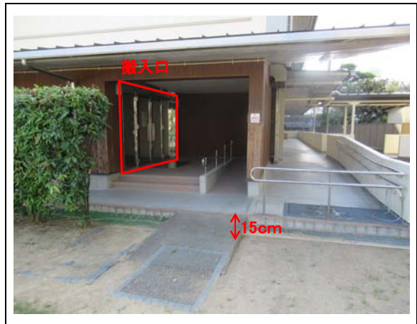
③搬入口(近景)
