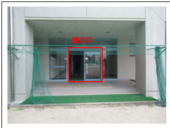
④搬入口(近景)
