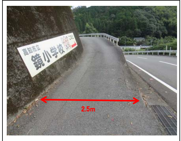
②進入路 道幅 2.5m
