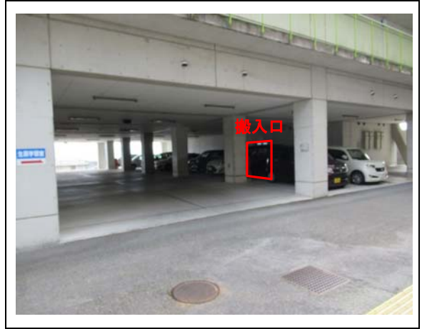
②搬入口(遠景)
