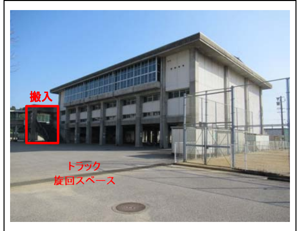
②搬入口(遠景)
