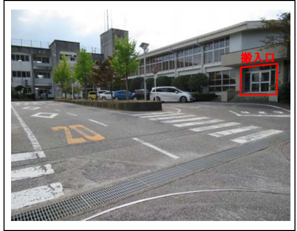
②搬入口(遠景)
