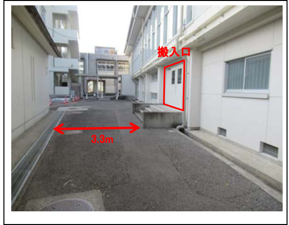
②搬入口(遠景) 道幅 3.3m
