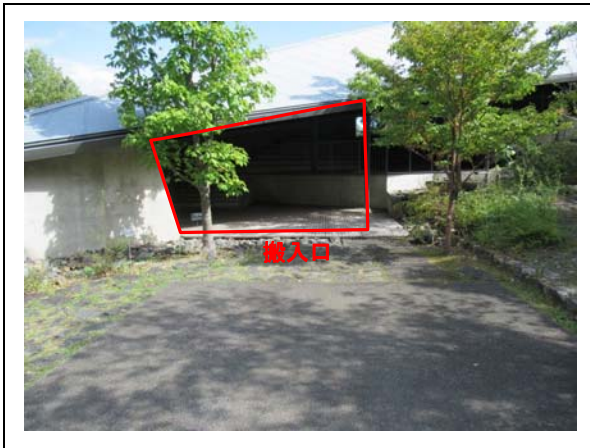
④搬入口(近景)
