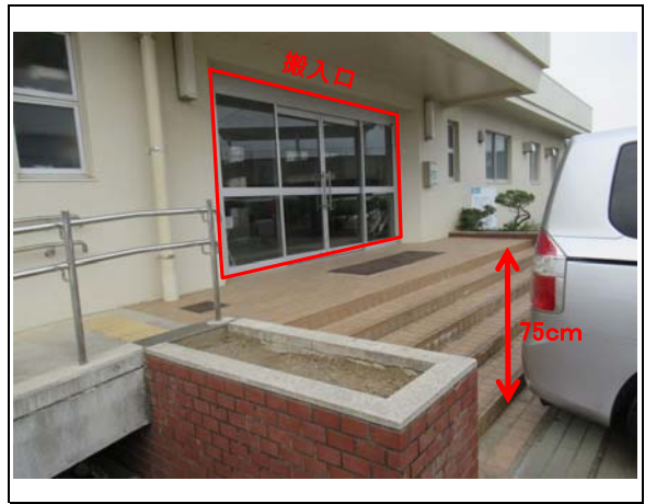
③搬入口(近景)
