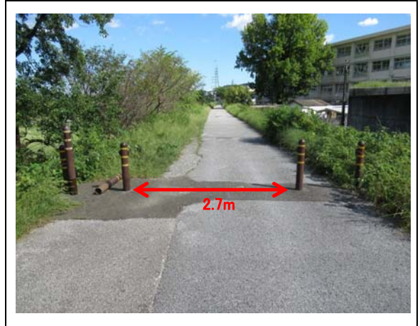
②進入路 道幅 2.7m
