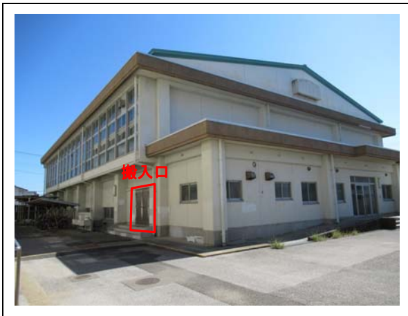
③搬入口(遠景)
