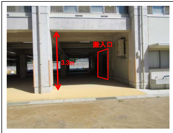
③搬入口(遠景)
