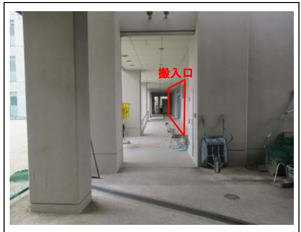
④搬入口(遠景)
