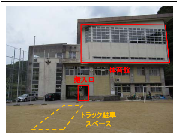
③搬入口(遠景)
