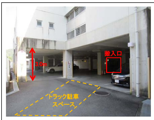
③搬入口(遠景)
