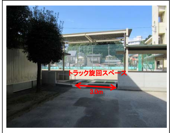
②進入路 道幅 3.0m
