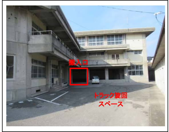
②搬入口(遠景)
