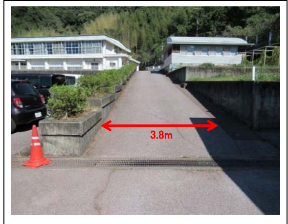
②進入路 道幅 3.8m
