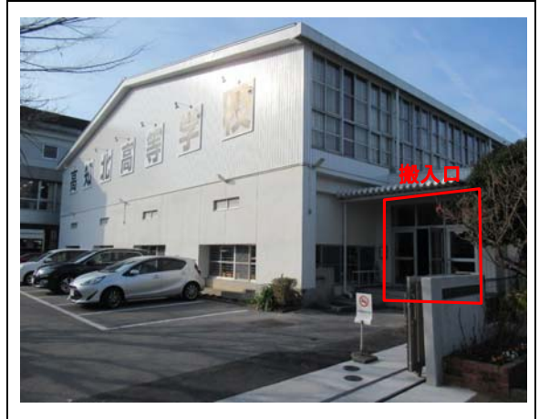
②搬入口(遠景)
