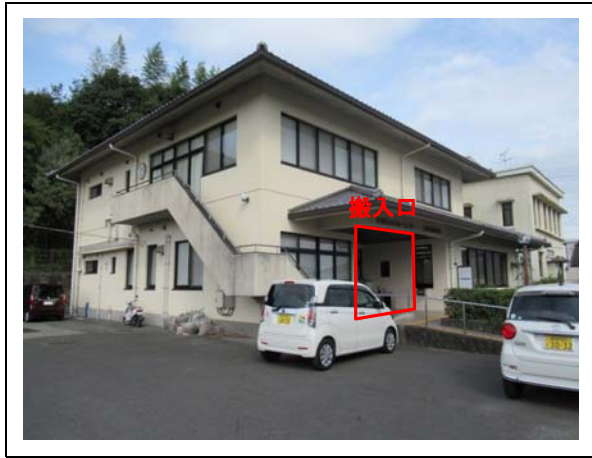
③搬入口(遠景)
