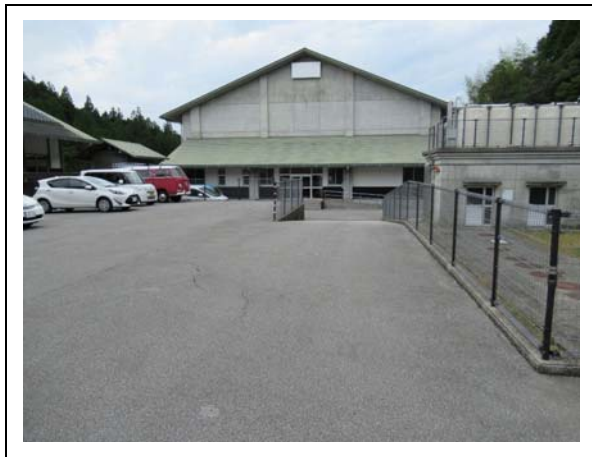
③搬入口(遠景)
