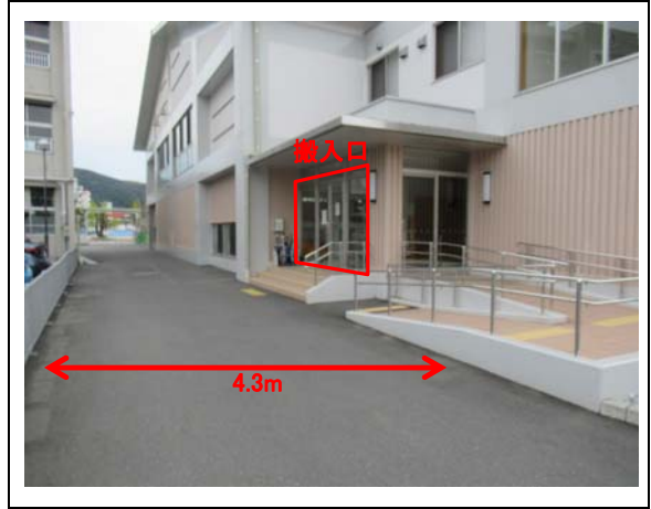
②搬入口(遠景) 道幅 4.3m
