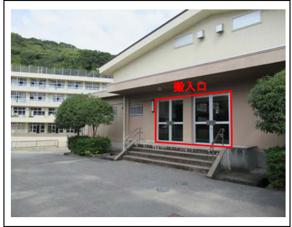
②搬入口(遠景)
