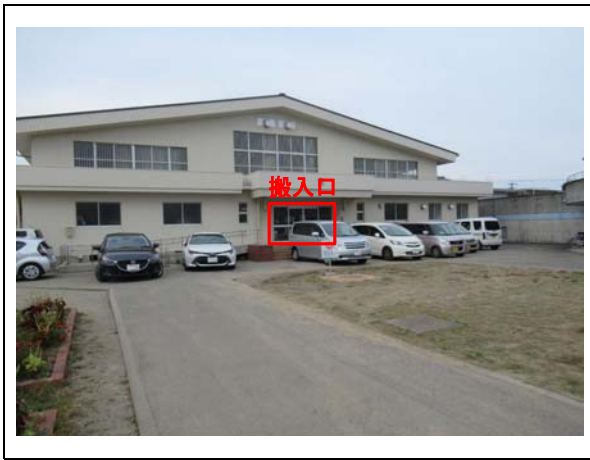
③搬入口(遠景)
