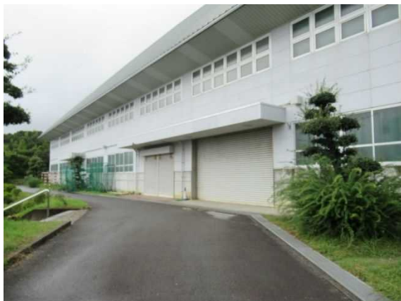
図 3-2 屋内運動場外観
