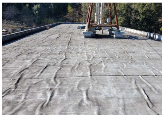
事例写真 屋上防水工事(施工前・後)
