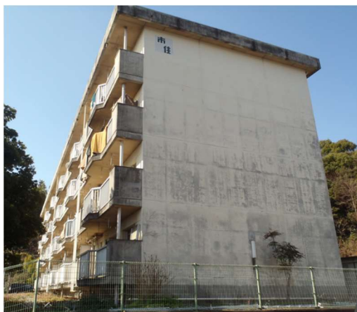
事例写真 外壁改修工事(施工前・後)
