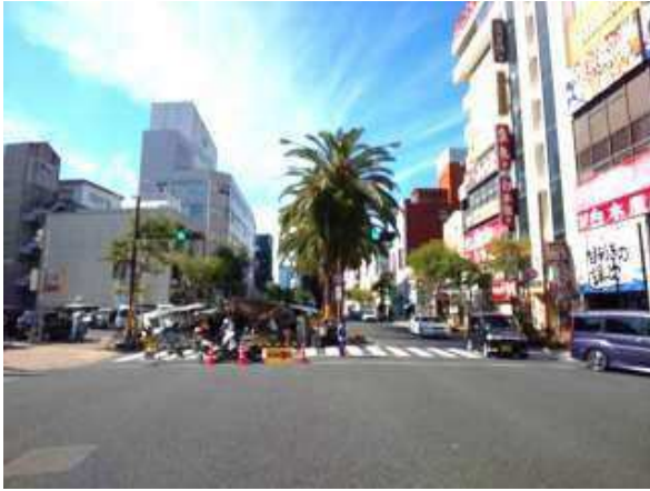
・高知街 1 号線の通行規制の様子
