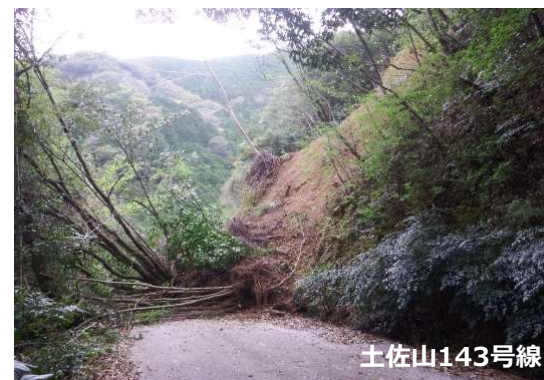
土佐山桑尾 崩土撤去，仮設土留め L=50m H=20m
