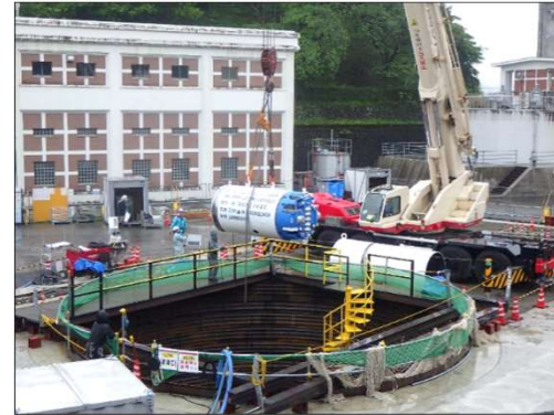
シールドマシン搬入状況（旭浄水場）
