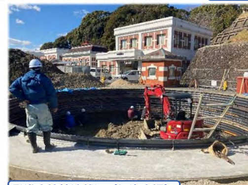
発進立坑築造状況（旭浄水場）
