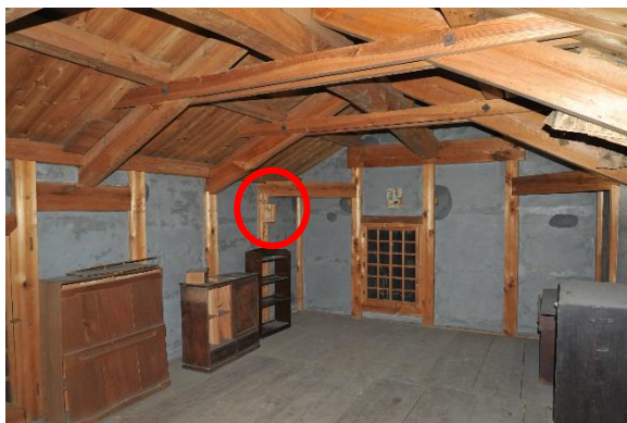
写真1 祈祷札箱の状況（南東より見る）
