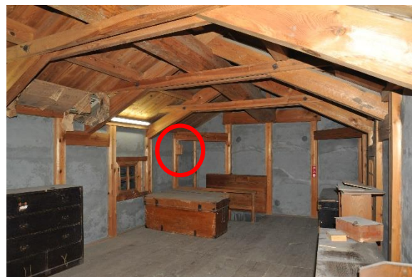
写真2 祈祷札箱の状況（北西より見る）
