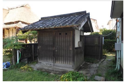
写真 3-4 便所 西より見る (建具あり)
