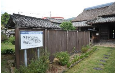
写真 3-9 板塀南 東面より見る
