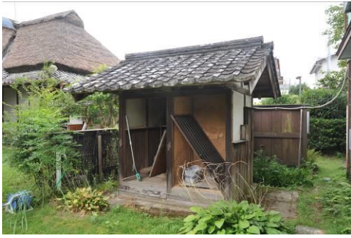
写真 3-3 便所 西より見る
