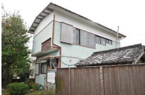
写真 3-1 管理棟 北東より見る
