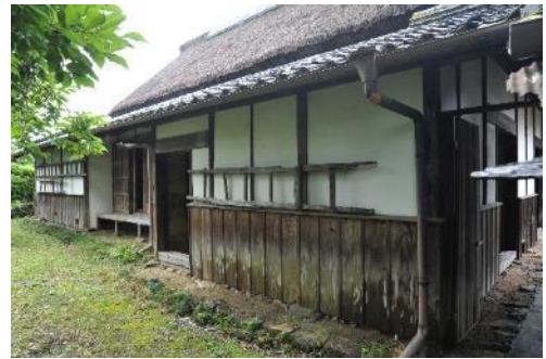
写真 2-2 主屋 北面より見る
