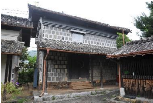
写真 2-16 道具倉 東面より見る
