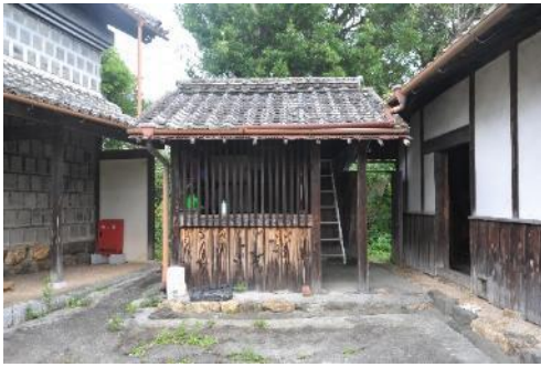
写真 2-40 水屋 南面より見る
