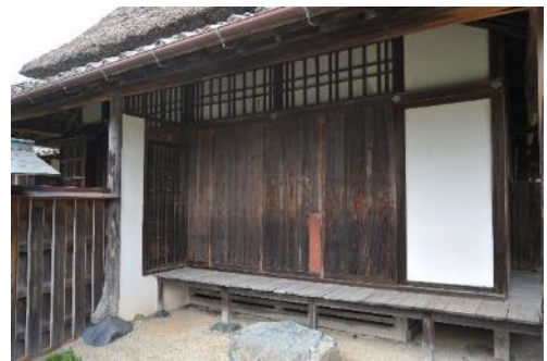
写真 2-11 主屋 雨戸戸板の補修
