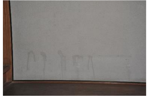
写真 2-9 主屋 「ざしき」トコ廻りの雨垂れ
