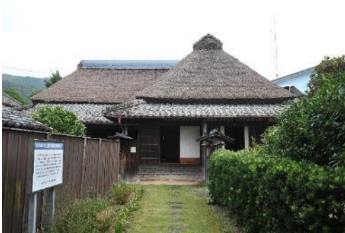
写真 2-1 主屋 南面より見る
