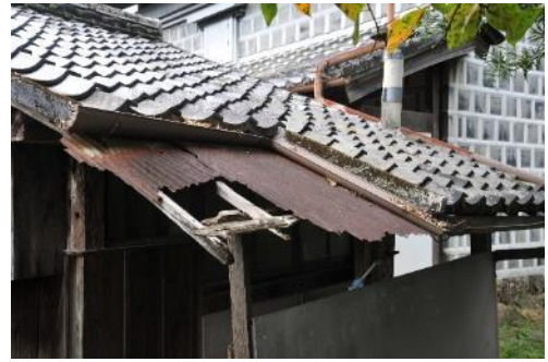
写真 2-41 水屋 北東隅のトタン葺
