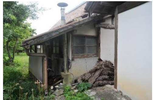
写真 2-43 水屋 東側風呂焚口
