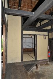
写真 2-6 主屋 「どま」より「とりのま」を見る
