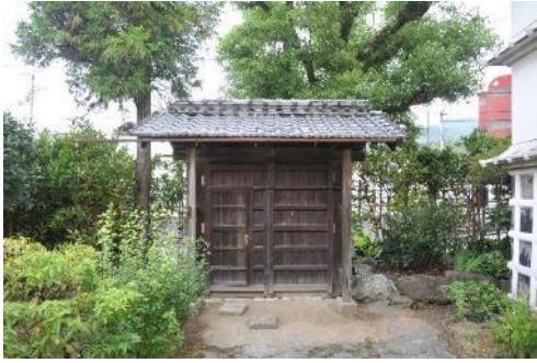
写真 2-36 裏門 東面より見る
