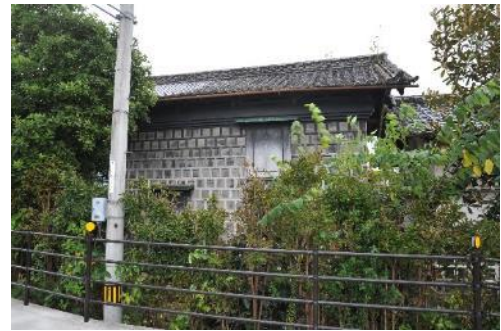
写真 2-17 道具倉 西面より見る
