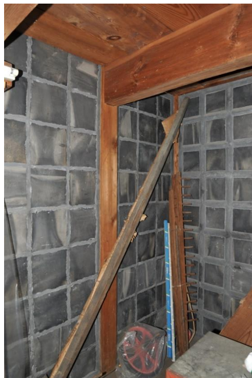
写真 2-26 道具倉 1階壁面の海鼠壁
