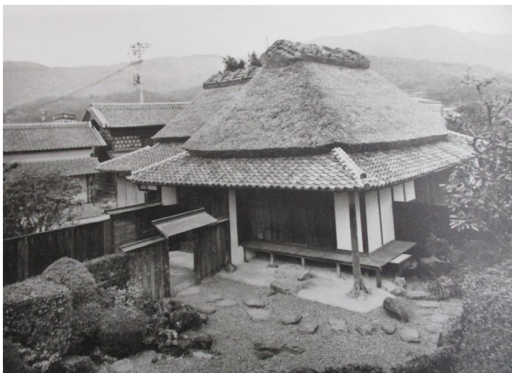
写真 1-1 昭和 51(1976)～52(1977)年 保存修理 主屋竣工写真
