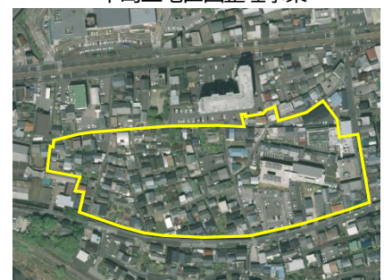
H25 工事着手前
