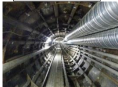
シールド内部（一次覆工）
