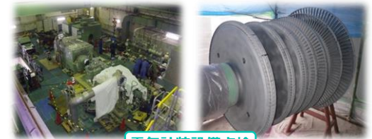
電気計装設備点検
