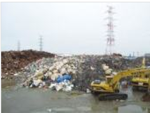
一次仮置場での重機作業
