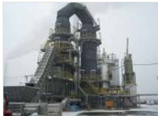
（仮設焼却施設）
