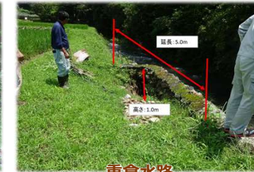
重倉水路 護岸復旧修繕
