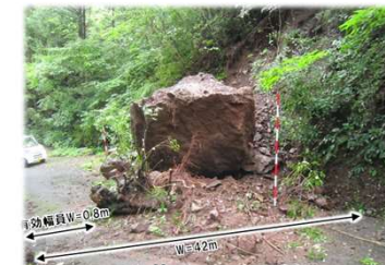
土佐山132号線 岩石及び崩土撤去 L=8m
