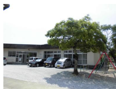
一宮老人福祉センター（北西から）
