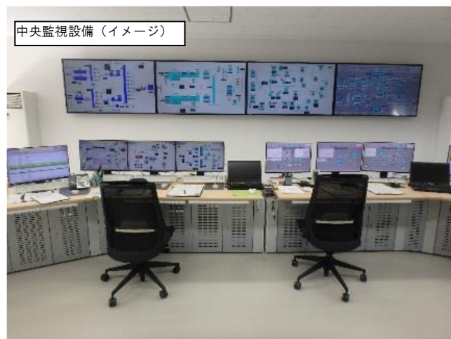
管理棟電気設備更新（下知水再生センター）
