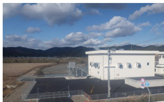
仁ノ第二排水機場
