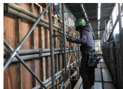
▲ 型枠は職人さんが1枚1枚工具を使って打ち付けます。
