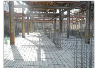
▲ 作業構台の下にも鉄筋が張りめぐらされています
