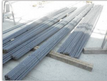
▲ 搬入された鉄筋。色んな長さの鉄筋があり、1本で約70kgのものも！
