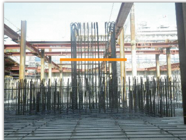
▲ 真ん中にある鉄筋部分にコンクリートを打設すると柱になります(ちなみに、地下1階の床の高さは橙線の高さになります)
