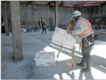
▲ 捨てコンクリートを打設して、その高さのチェックをしています
