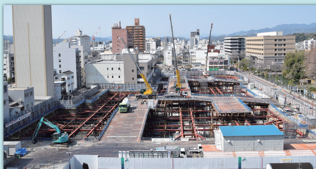
▲現在の工事の様子
