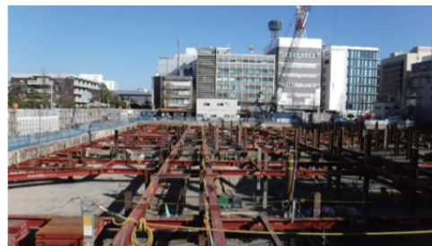
▲鋼製の切梁(つっぱり棒)が施されたようす
