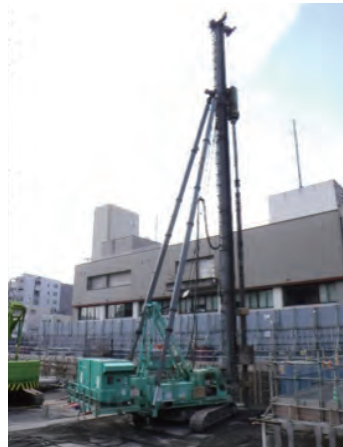
▲杭芯を確認して、重機(アースオーガー)で地盤を掘削します。
