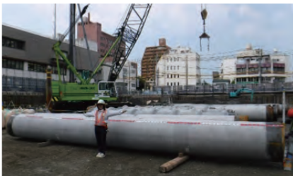
◀直径1メートルの既製コンクリート杭。杭の中には大人も入れます。
