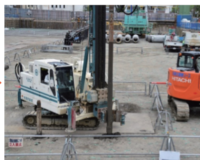
▲丸太の押し込み完了！押し込み棒を引き上げています。
