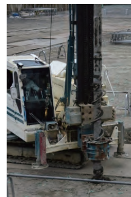
▲先端のドリルで土をほぐしています。
