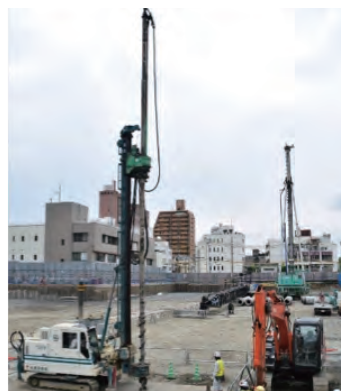
▲左の重機で土をほぐし丸太の押し込みを行い、右の重機(ショベルカー)は丸太のセッティングをします。
