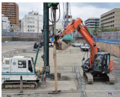
▲土をほぐした所に、クレーン仕様のショベルカーを使って丸太をセットします。
