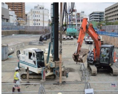
▲左の杭打機でセットした丸太を押し込んでいます。
