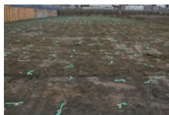
▲丸太杭を打つ場所には、緑のリボンの印をつけます(杭芯出し)。
