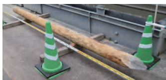
◀1本の丸太。鉛筆のように片方の先を削り、こちらを下側にして杭を打ちます。
