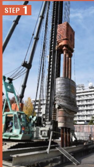
▲ 山留工事用の重機。3本のドリルで穴を掘り、土とセメントをミックスしていきます。
