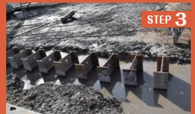
▲ 鋼材建て込み完了。周りのセメントが硬化したら山留完成です。
