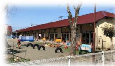
【愛善保育園（耐震補強）】
