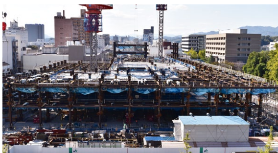
建設中の新庁舎（10月19日撮影）
