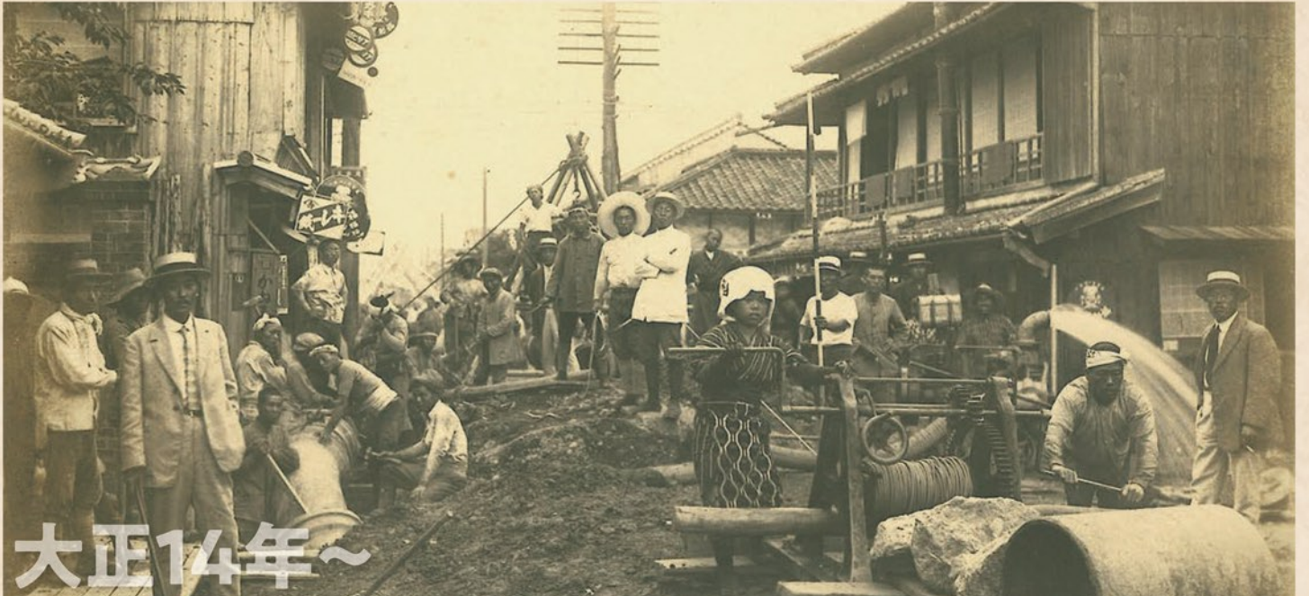
水道管の布設工事の様子（中島町・大正14年）
