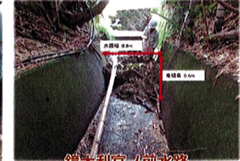
鏡大利宮ノ前水路 水路浚渫
