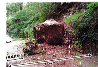
土佐山132号線 岩石及び崩土撤去 L=8m
