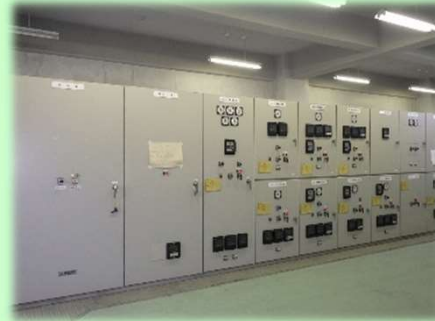
電気室 (電気供給機能)
