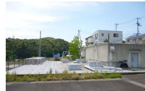
蒔絵台汚水中継ポンプ場の外観
