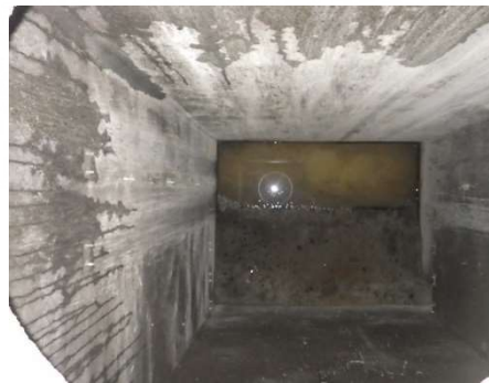
浄化槽内部（機器の撤去、清掃後）
