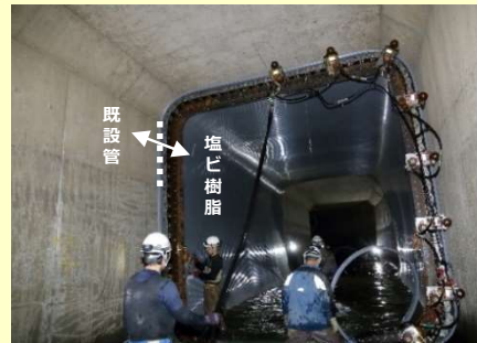
◇ 中部合流幹線の管更生
