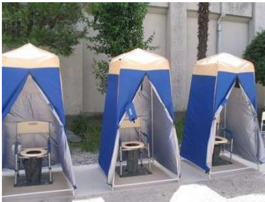
マンホールトイレの設置状況 (長岡京市)
