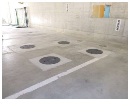
浄化槽上部を改修
