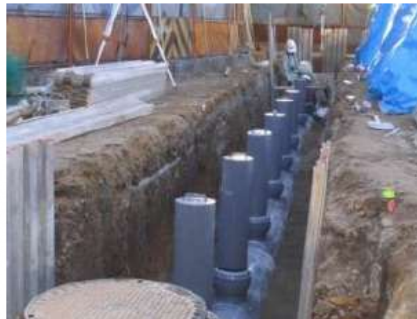
マンホールトイレの施工状況（地下部） (長岡京市)
