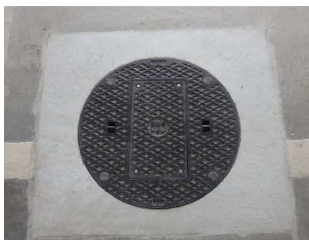
マンホールトイレ用の蓋
