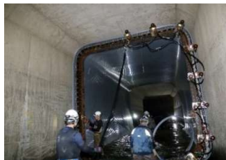
管渠の耐震化
