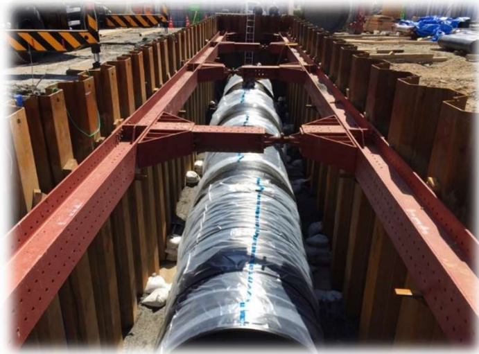
耐震性非常用貯水槽設置時の土留工
