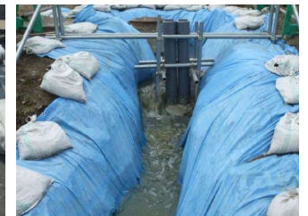
素堀水路+ブルーシート (青森県八戸市)
