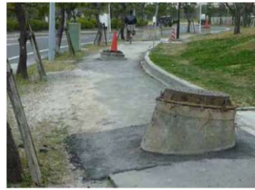
液状化によるマンホール突出
