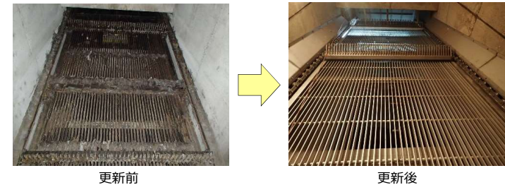
設置から30年以上が経過した海老ノ丸ポンプ場の除塵機（スクリーンに付着するゴミの掻き揚げ装置）を更新しました。
