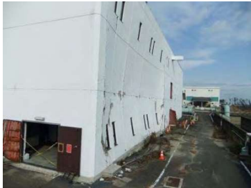
外壁の被災状況①
