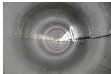
江ノ口雨水貯留管（完成）
