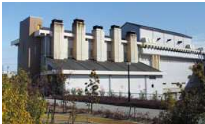
海老ノ丸ポンプ場
