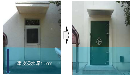
◇下知水再生センター送風機棟の防水化
