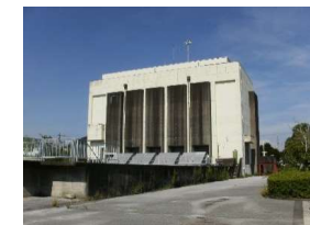
長浜原ポンプ場
