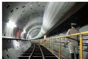
江ノ口雨水貯留管
