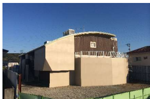
徳谷第二雨水ポンプ場
