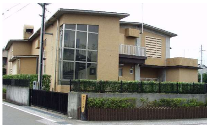
初月ポンプ場
