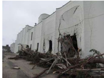
外壁の被災状況②
