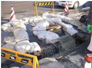
マンホールからの下水の溢水
