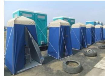
◇マンホールトイレの設置事例
