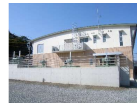
関雨水ポンプ場
