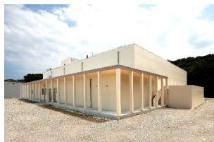
長浜雨水ポンプ場
