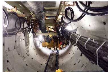
江ノ口雨水貯留管（施工中）
