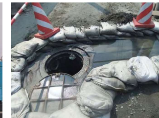
土のうによる仮設水路 (宮城県多賀城市)
