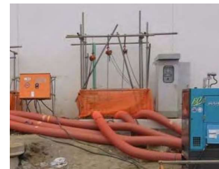
仮設ポンプによる汚水くみ上げ (宮城県石巻市)
