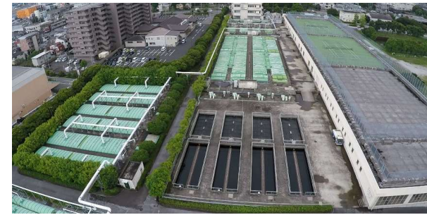
下知水再生センター
