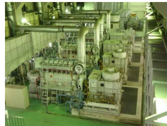
海老ノ丸ポンプ場
