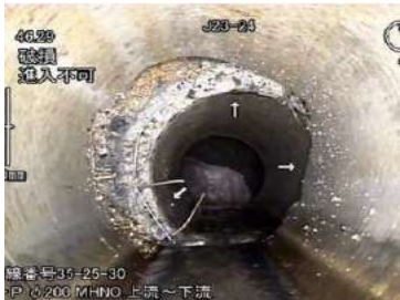
管路のずれ、破損状況
