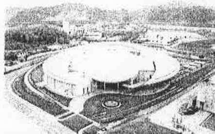
現在は天井工事のため10月末まで休館。
