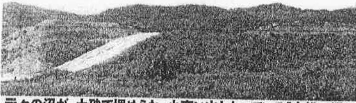
元々の沼が、土砂で埋められ、小高い山となっている「小松の沼」
