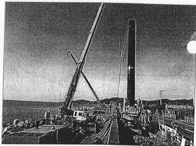
鋼管杭施工状況(戸原工区)
